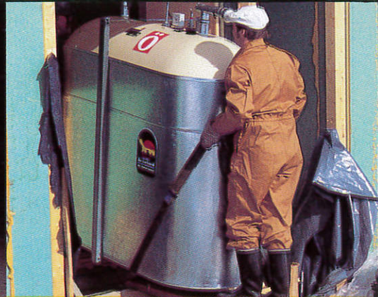
Valuma-altaalla varustettu 1500 litran ö-säiliö mahtuu sisään 73 cm leveästä ovesta.
